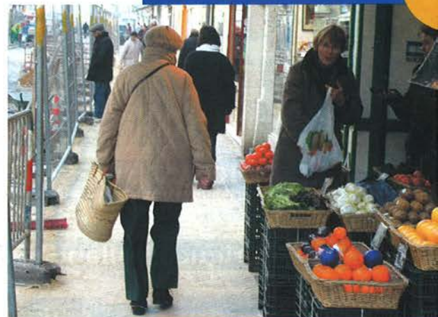
L'une des préoccupations dans l'organisation des travaux a été de maintenir en permanence l'accès des piétons à l'artère commerçante.
