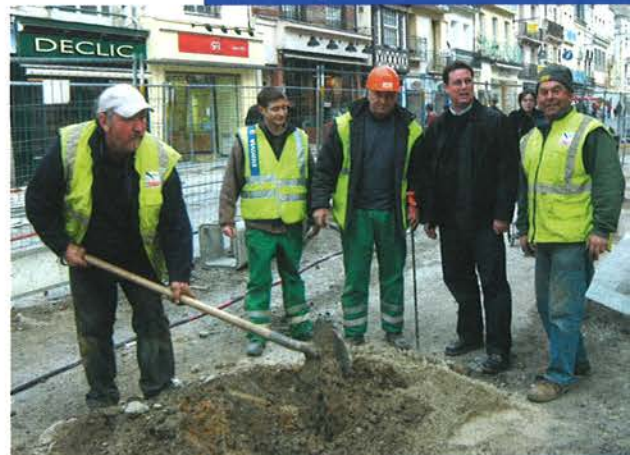
Frédéric Malo (2 e à droite), responsable du projet chez Sogeti, assure le suivi du chantier
