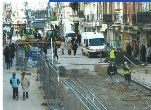
La pose du revêtement a été entamée à hauteur de la rue de la Morinière en direction de la place Nationale pour des raisons techniques de pente et de raccords. Ainsi, une fois terminée, la Grande rue servira de guide pour la place du Puits-Salé.
