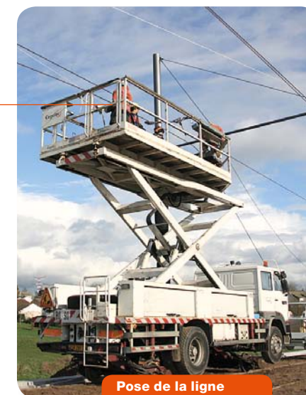
Pose de la ligne aérienne de contact
